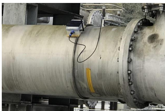
图 8 GIL 振动量在线监测节点安装布置图
